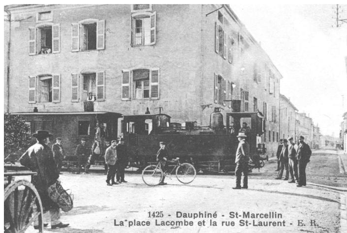
La morphologie atypique de cette locomotive est due à la présence à l'avant d'une deuxième cabine. Offrant une meilleure visibilité, elle était utilisée par le conducteur lors de la traversée de villages et des rues de Lyon. Il n'existe plus aucune autre machine à voie métrique de ce type.
